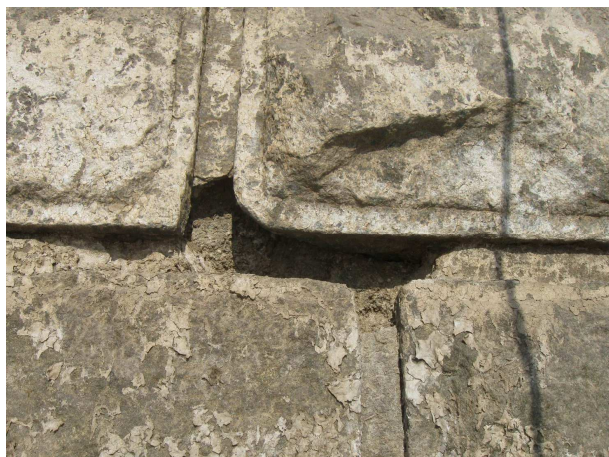
Obr.3 - Detaily porušeného spárování
