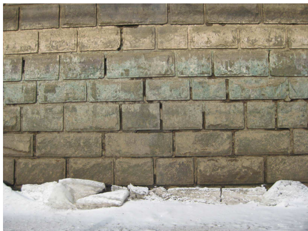
Detaily poškození spár 1
