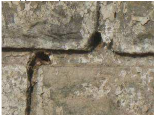
Detaily poškození spár 1
