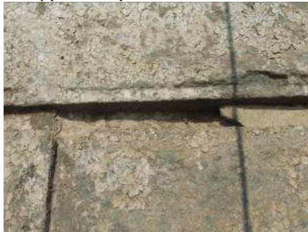
Detaily poškození spár 2
