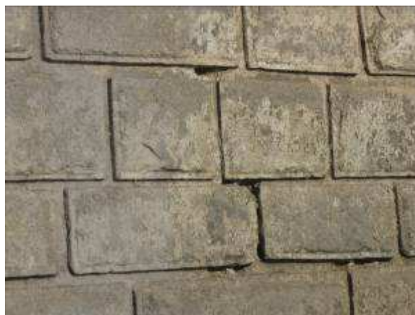
Detaily poškození spár 4
