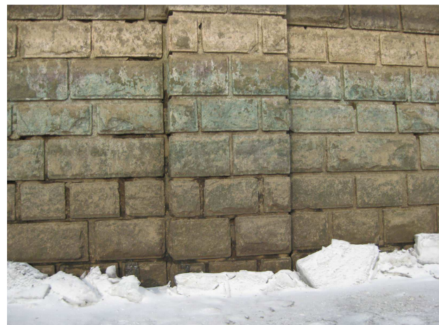
Detaily poškození spár 2
